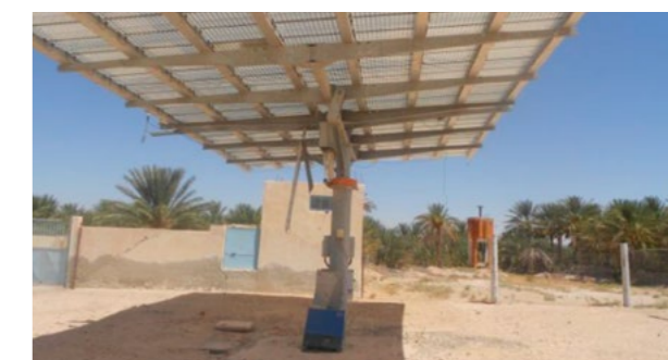
Figure 20 Les panneaux photovoltaïques au service de la biodiversité
